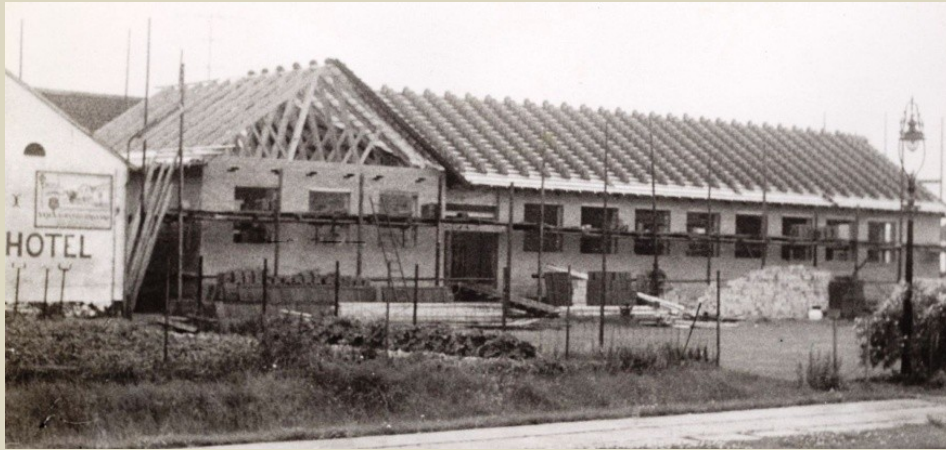
Ny fløj under opførelse i 1964.
