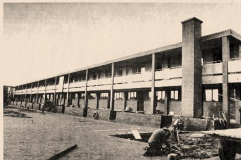
Det nye altangangshus, som Vejen Boligforening har opført på Lærkevej, byder på mange fordele. Hver lejlighed får sin egen indgang, så det giver fornemmelsen af at bo i et rækkehus og ikke i en etagebygning.
