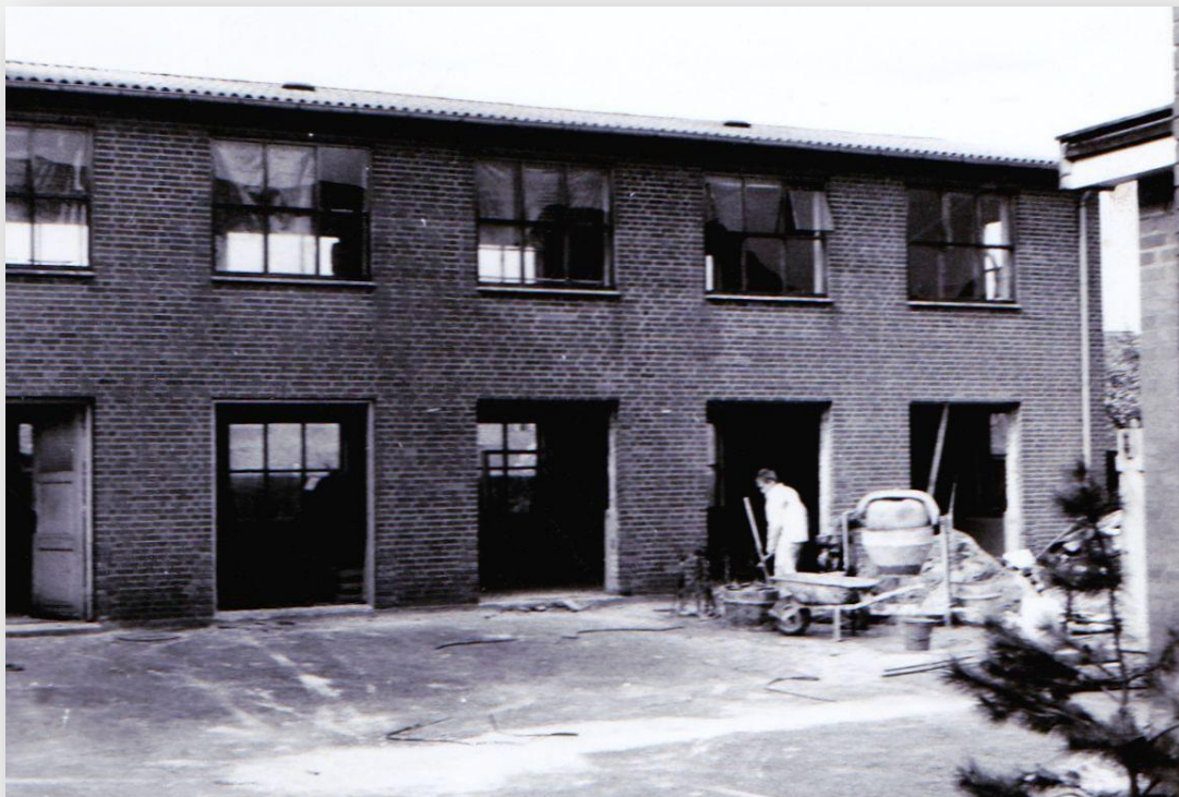
Søndergade 23 under ombygning.
