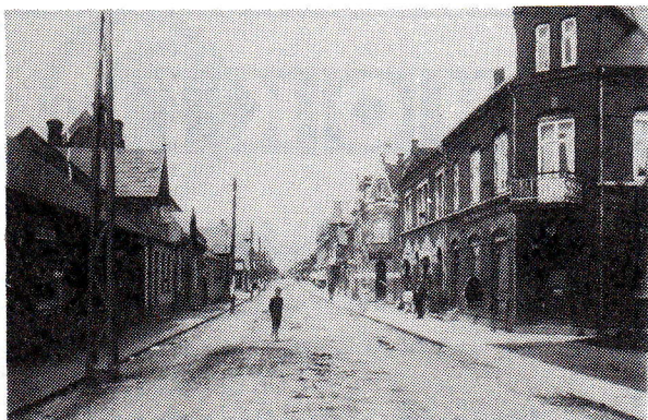
Vejen ændrede karakter fra landsby til stationsby. »Hullet« mellem den gamle landsby og stationen blev fyldt ud. Her Nørregade 1916.
