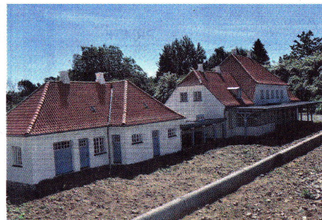
Den seneste bygning, der er kommet på plads i anlægget, er stationsbygningen. Byggeriet af den har taget omkring 1½ år.
