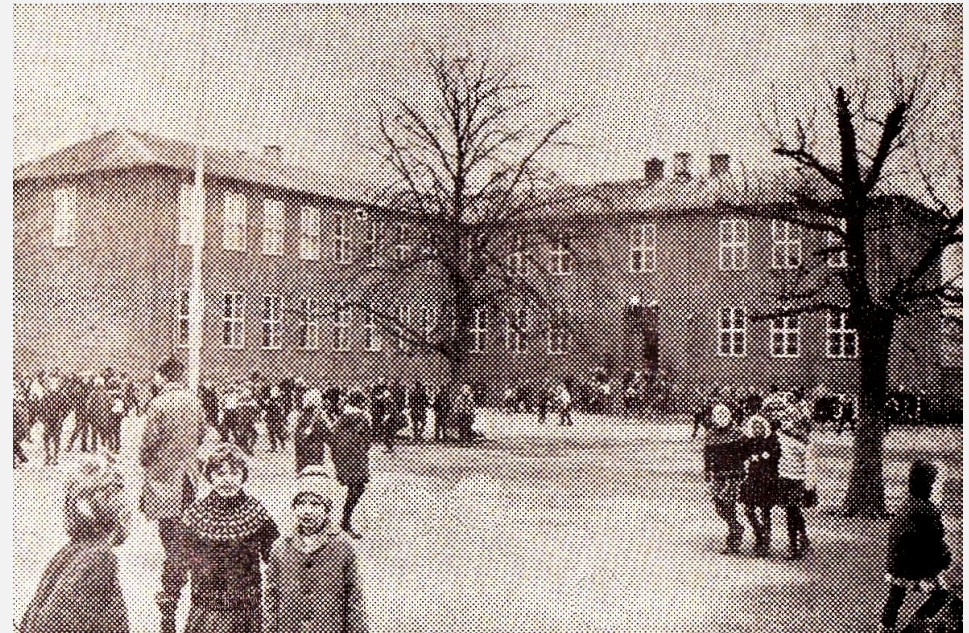
BYSKOLEN, der fra sommerferien frigøres og skal indrettes til specialskole for evnesvage i et samarbejde med 10 kommuner. Desuden skal der her indrettes tandklinik for skoleforbundsområdet.
